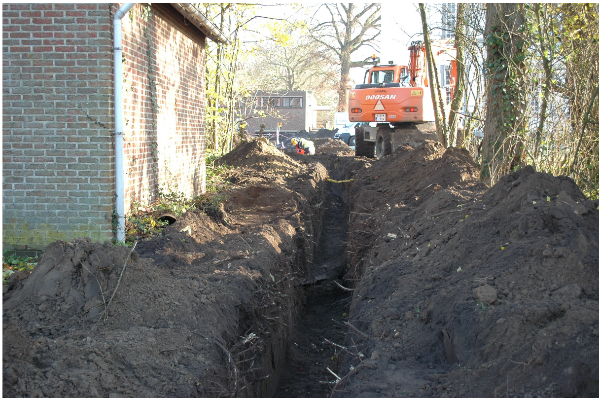
Fig. 2.1: Aanleg van de aardgasleiding.
