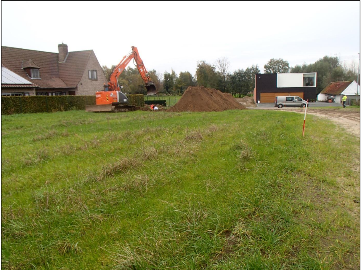
Figuur 2: Het op te graven terrein gezien vanuit het noorden.
