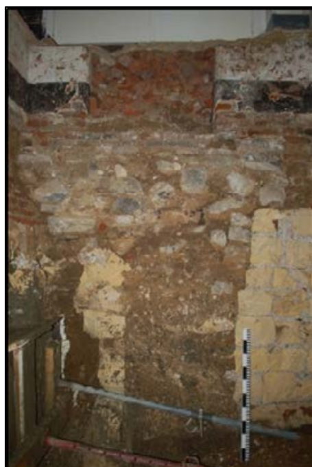
FIG.49 De aanzet van het tongewelf.
