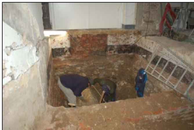
FIG. 18 Het opschonen van vlak 1 in werkput 2.
