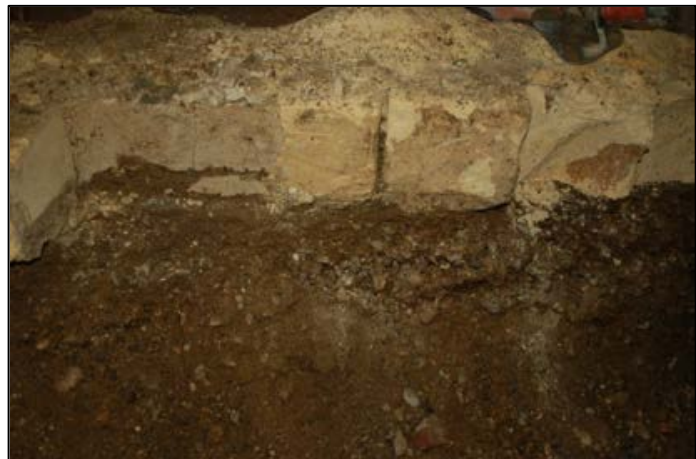
FIG. 17 De kiezellaag onder de funderingen van de keldermuren.
