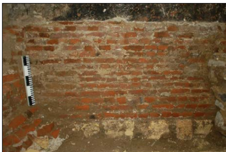
FIG. 26 De westelijke fundering van de kerk in werkput 2.
