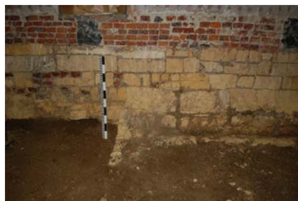
FIG. 36 De nieuwe noordelijke fundering in Maastrichtersteen aangelegd over een oudere fundering.
