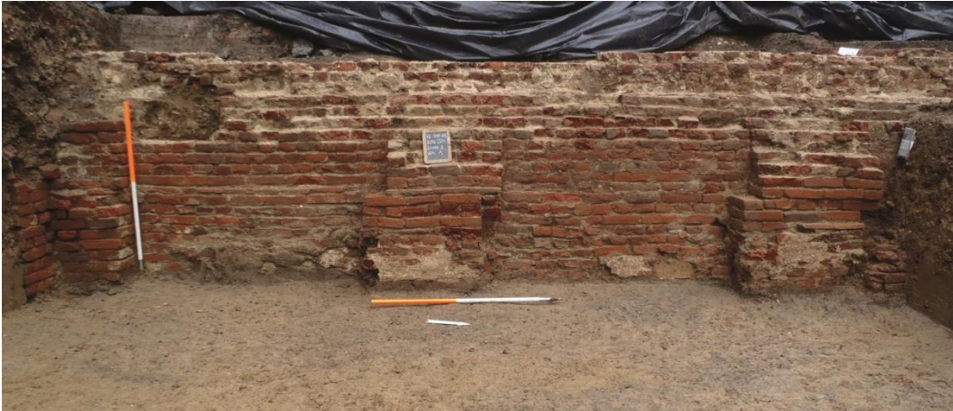
Figuur 87: Muur met steunberen rond de pandhof.
