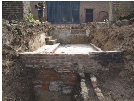
Figuur 32: Noordelijke buitenmuur.
