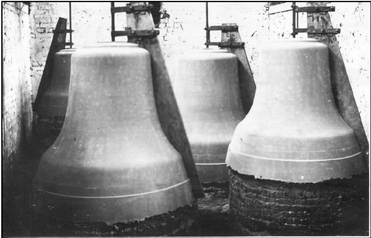
Figuur 32: Zicht op enkele afgewerkte lemen kernen in de Koninklijke Klokkengieterij Petit & Fritsen uit 1916.
