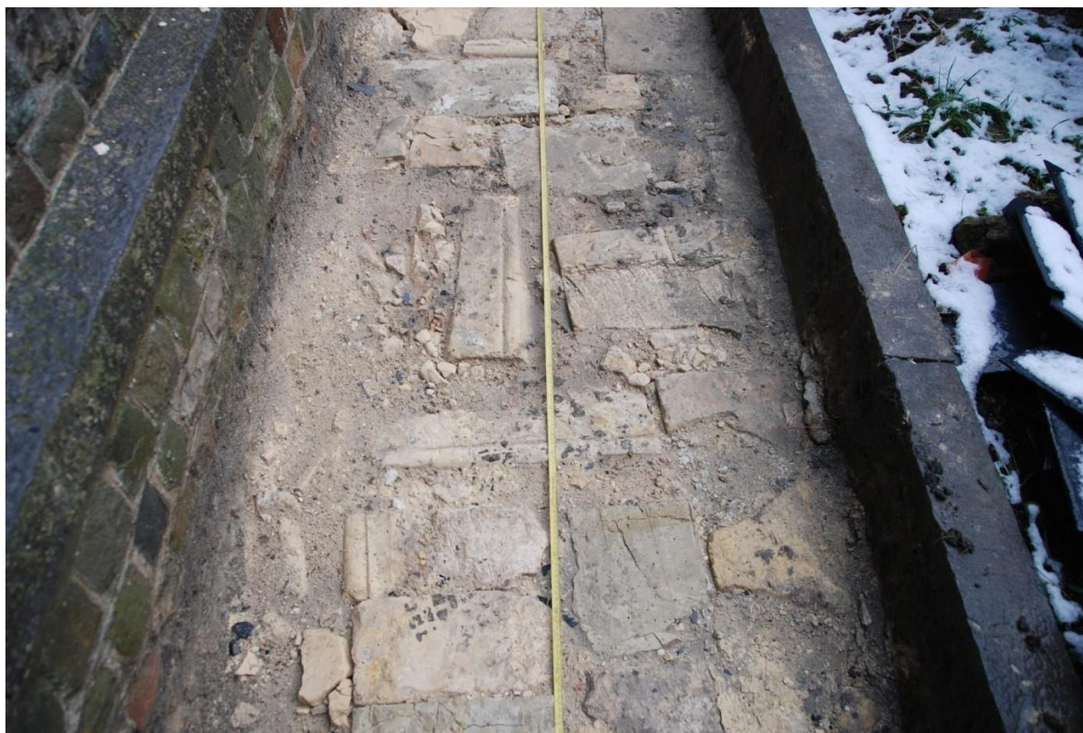
Fig. 6: Mergelpad met herbruikt materiaal.
