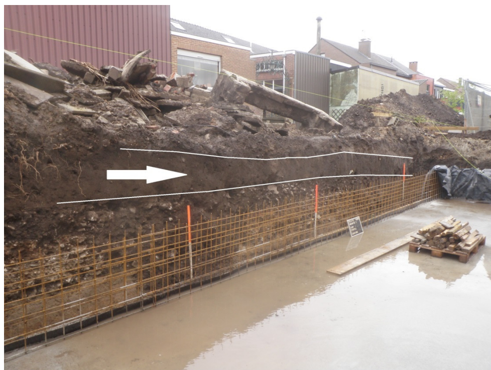
Afbeelding 15: profiel 1 met zicht op het recente puinpakket en de onderliggende 'zwarte laag'.
