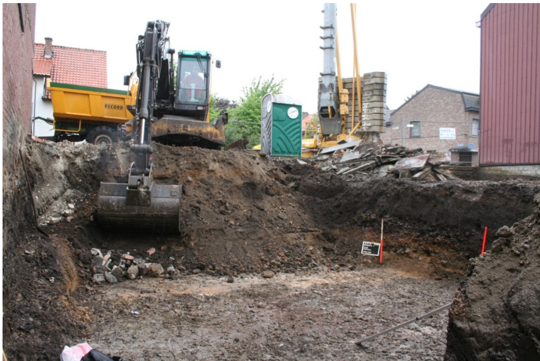
Afbeelding 14: Het aanleggen van werkput 1.
