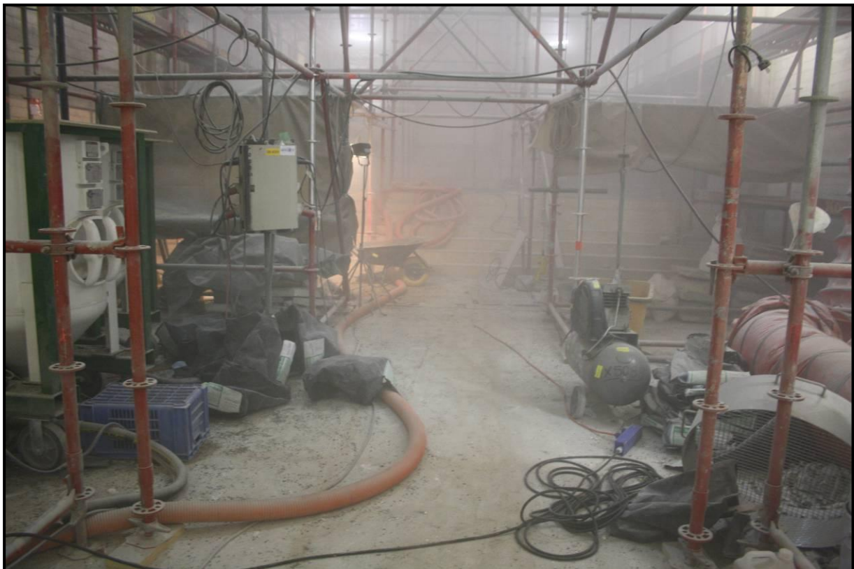
Figuur 11: Zicht op het laagkoor en de 4 machines die nodig waren voor het zandstralen.
