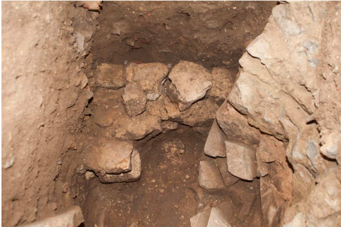
Bovenaanzicht van de onderste funderingssokkel. De zanderige mortel bevat veel grote kalknodules.
