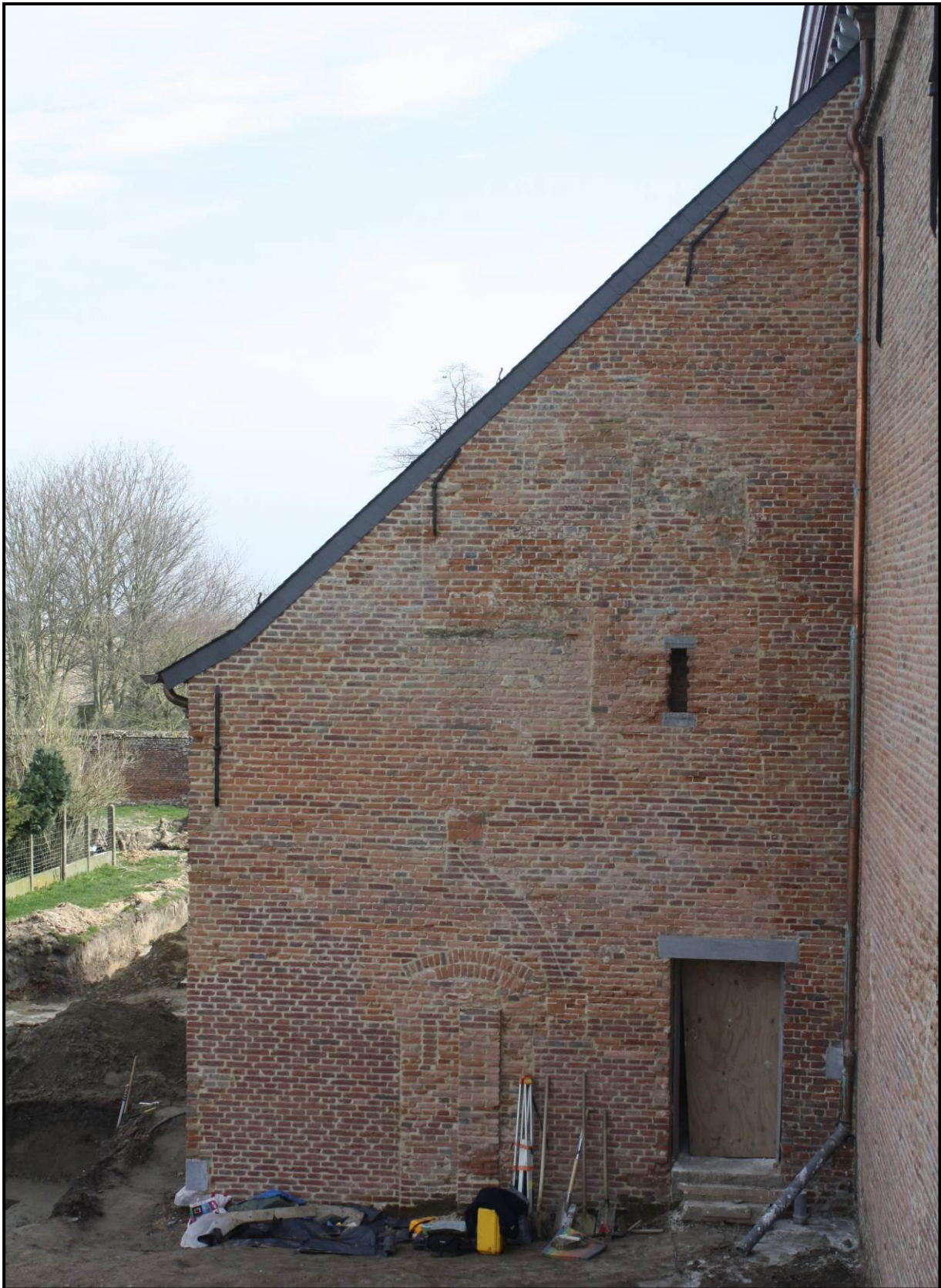
Figuur 31: De dichtgemetste oorspronkelijke doorgang van het kloosterpand naar de vermoedelijke kapittelzaal en/of de bovenste slaapvertrekken die overeenkomen met de bakstenen muren gevonden in sleuf 23, zijnde de toekomstige sanitaire ruimte.
