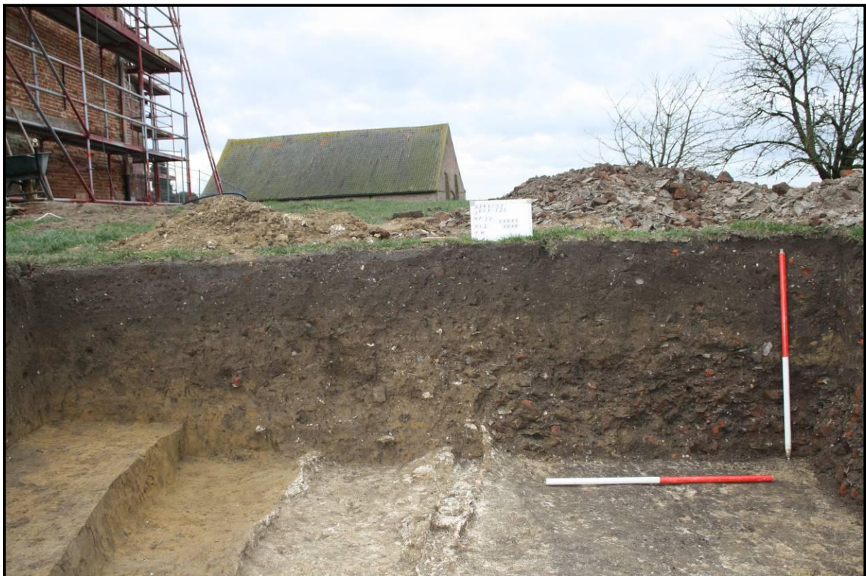
Figuur 130: P41 (westprofiel) in WP12.
