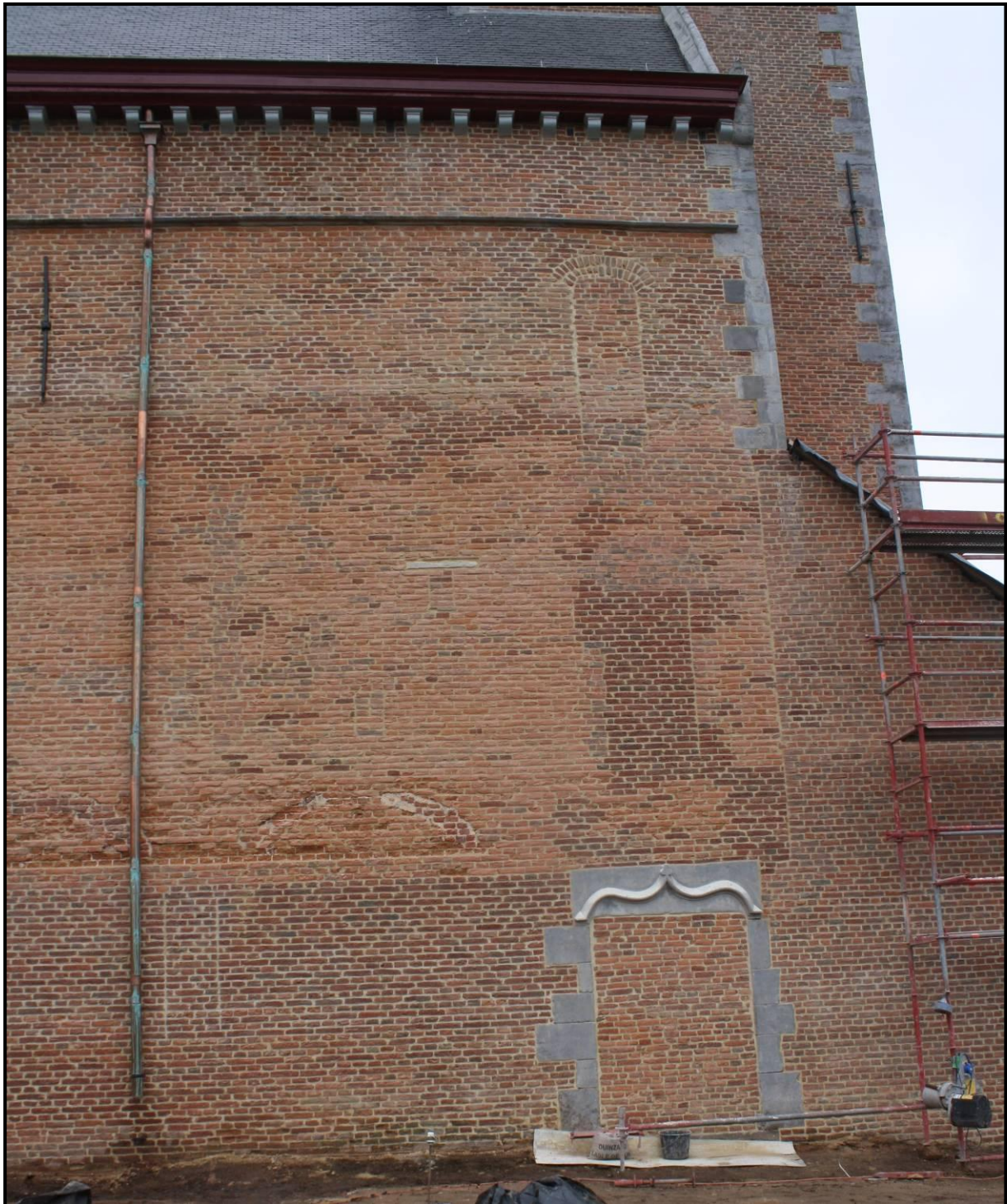
Figuur 29: De noordwestelijke doorgang van de kerk naar het kloosterpand die overeenkomt met de natuurstenen muur S174 binnenin de kerk in WP6. Merk ook de resten van de oorspronkelijke toegangen tot de bovenste verdiepingen en de bogen van het kloosterpand op.
