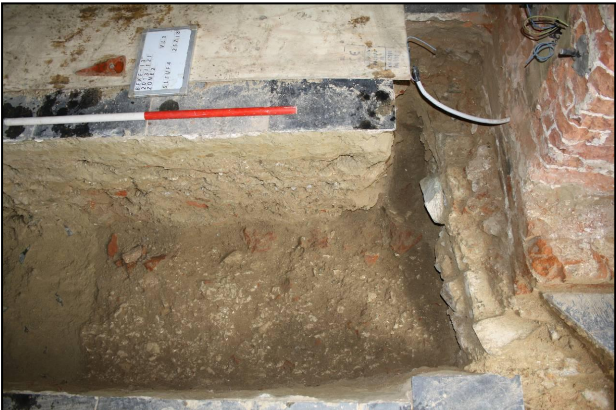
Figuur 48: S257 in vlak 3 van sleuf 4: verhard niveau van kalkmortel- en baksteenbrokken.
