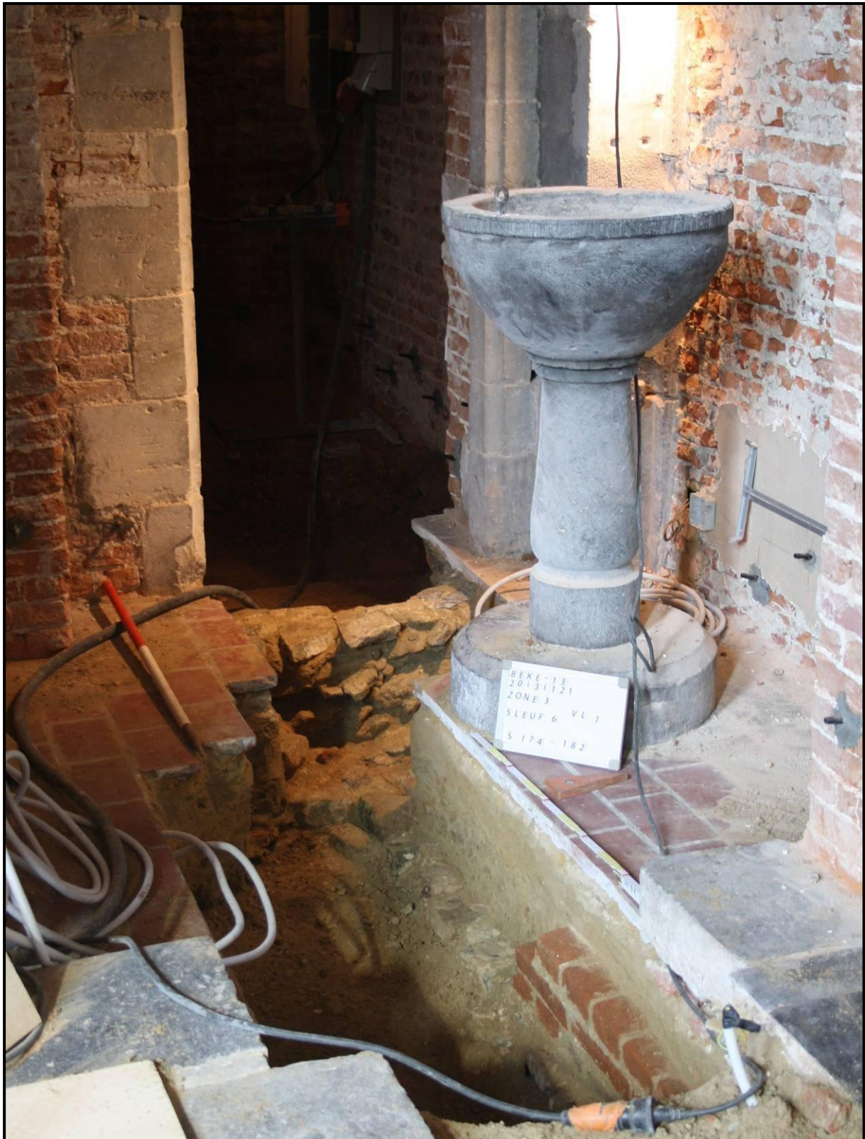
Figuur 28: Zicht op sleuf 6 in de doopkapel (zone 3) met rechts op de voorgrond de bakstenen constructie en achteraan de natuurstenen N-Z muur.
