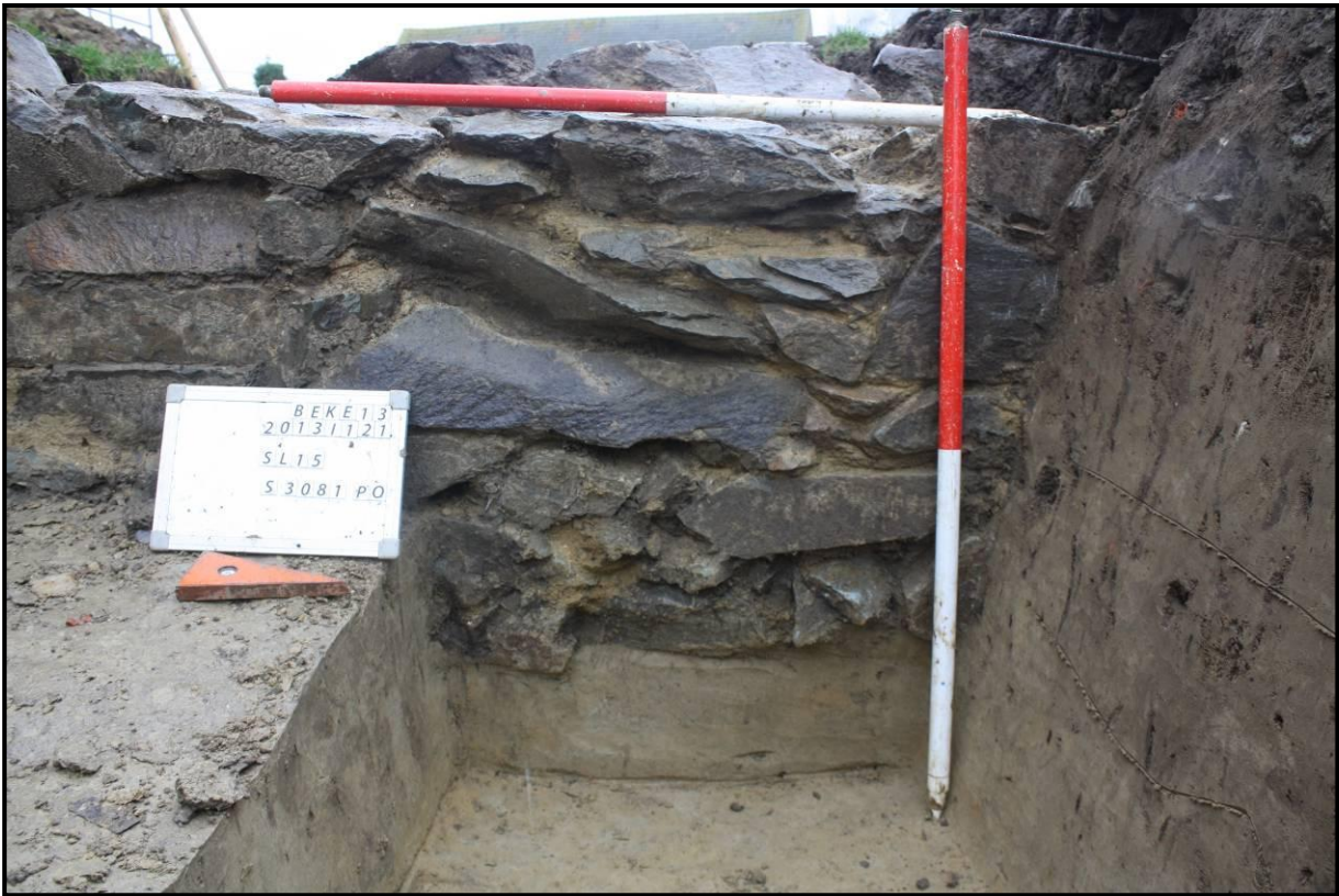
Figuur 84: Zicht op de verdieping langs de oostzijde van S3081.
