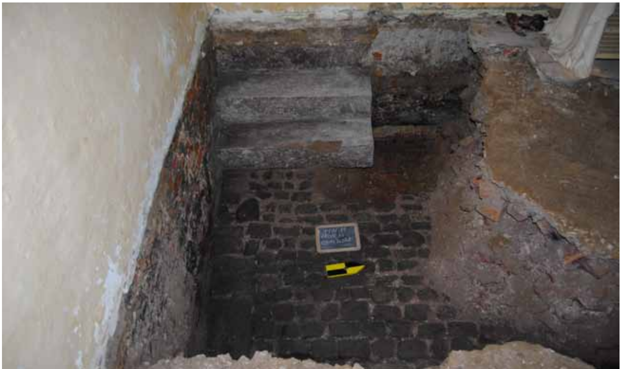
afb. 7: Tegelvloeren en recente constructies in vlak A (Stad Gent, De Zwarte Doos, Stadsarcheologie)
