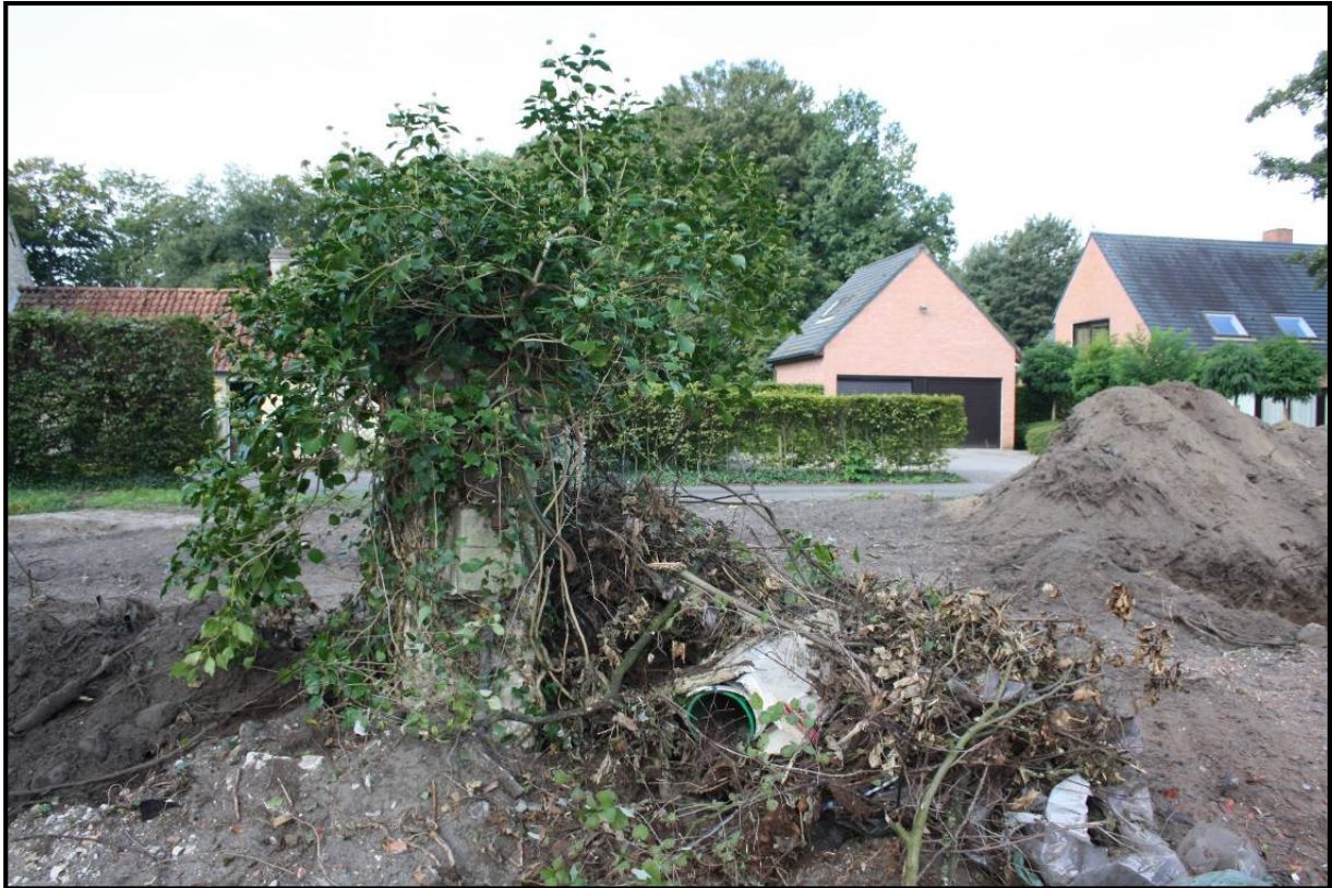
Figuur 25: De bovengrondse waterpomp.
