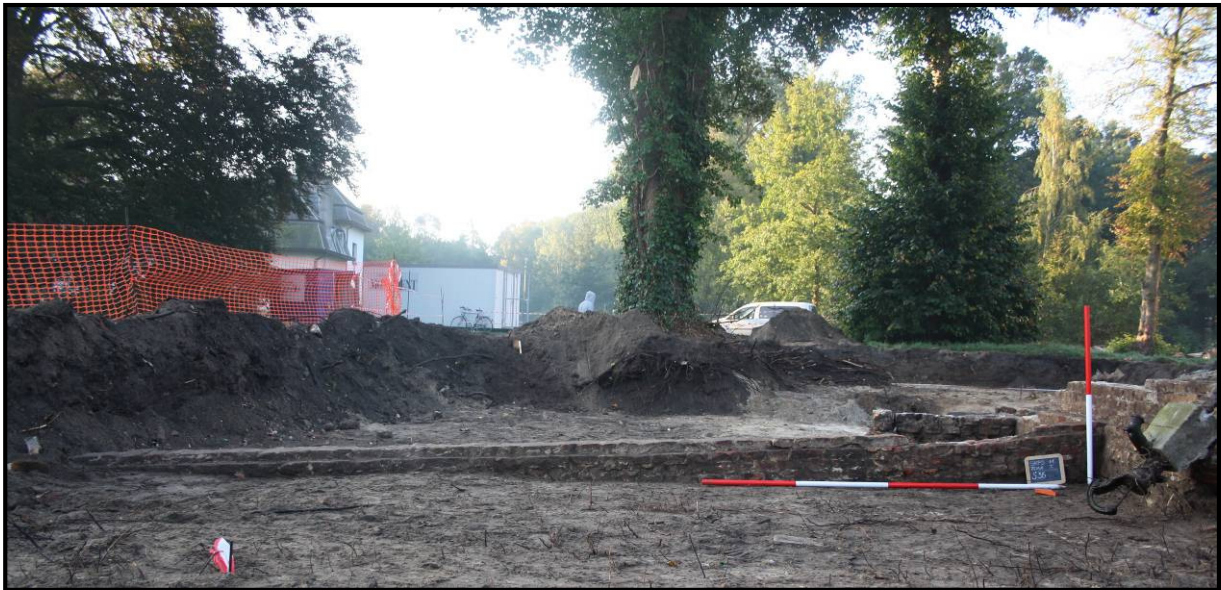
Figuur 27: S36, afwateringskanaaltje naar de gracht.
