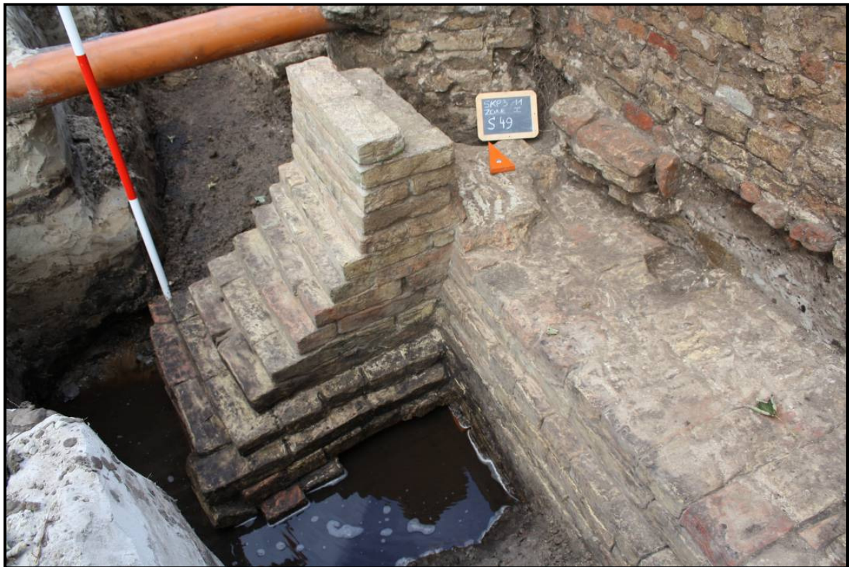
Figuur 22: Steunbeer langs de oostelijke gevel, aan de binnenkant.
