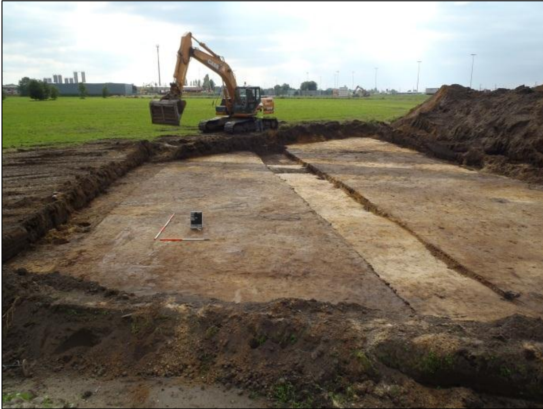
Figuur 16: Aanleg van het vlak.
