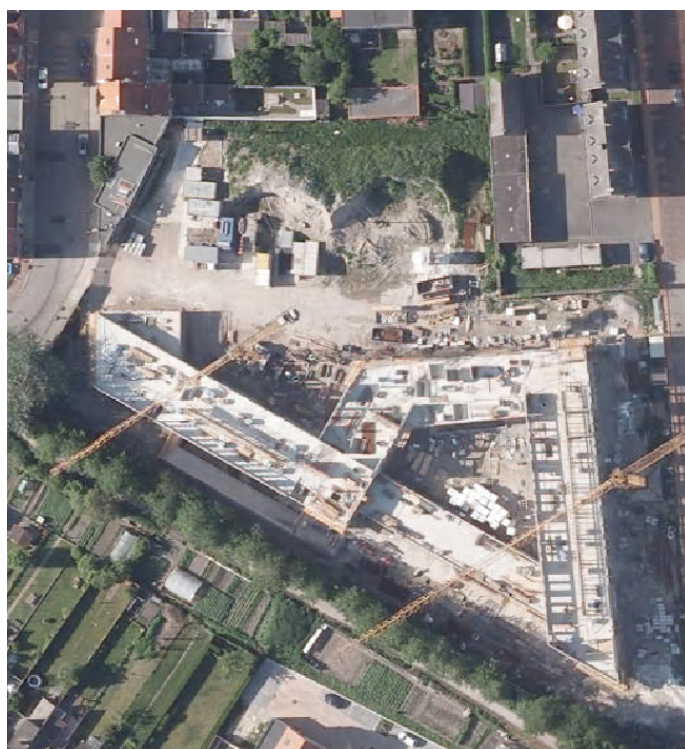
Luchtfoto tijdens de uitvoering van de werken, 2012 (Agiv)
