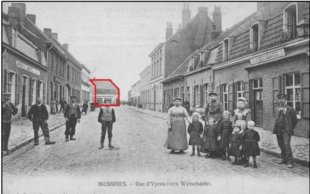
Figuur 48: Zicht vanuit de Ieperstraat richting het kruispunt Steenstraat – Ieperstraat. Het café-restaurant (aangeduid in rood) springt duidelijk naar voor ten opzichte van de rest van de bebouwing 32 .
