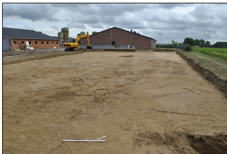
Afb. 8: Aanleg van het vlak op een diepte van ca. 50 cm.
