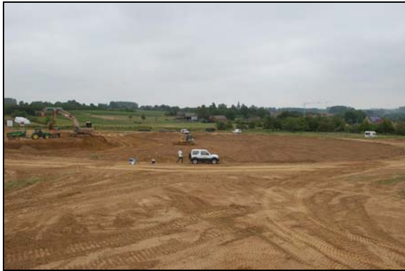
Fig. 5: Zicht op de werken aan het waterbekken.
