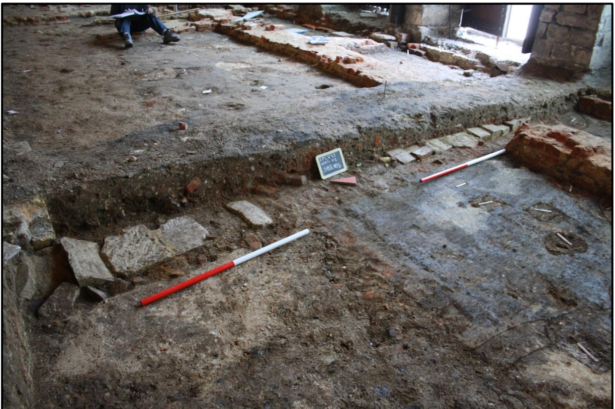
Figuur 38: S153, riolering met natuurstenen dekstenen in vak 4.
