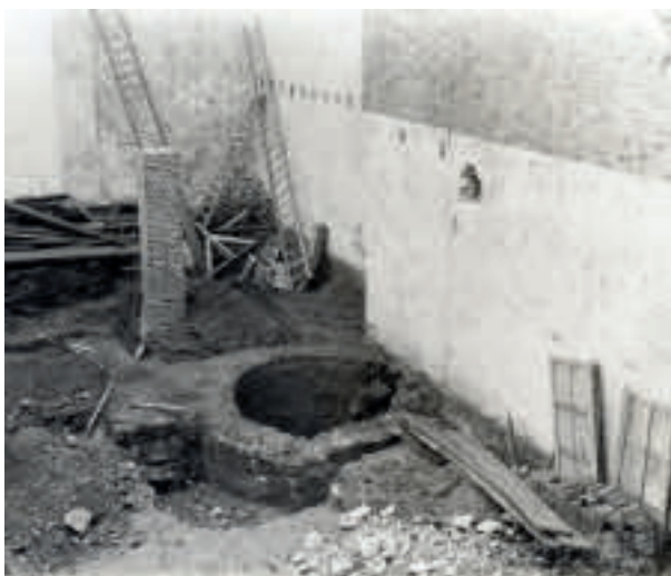
afb. 6: Foto uit 1896, gemaakt tijdens de bouwwerken voor het atelier dat in 2011 bij de start van de huidige bouwwerken afgebroken werd (Stad Gent, De Zwarte Doos, Stadsarchief, DK 8_10d)
