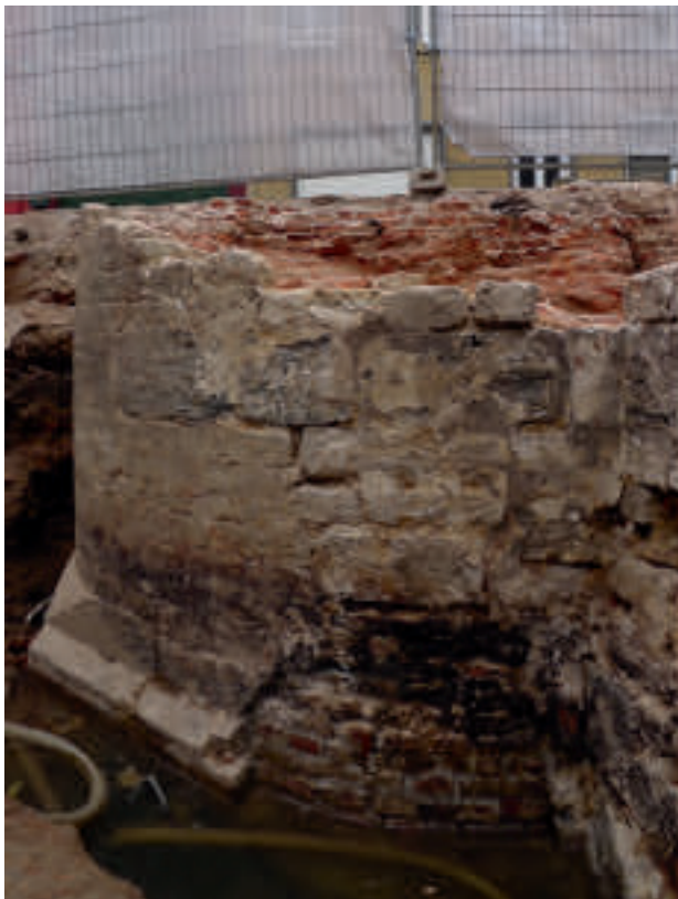
afb. 27: Het natuurstenen en plaatselijk herstellde buitenparement van de beide torens: de herstellingen werden weggewerkt met een witte kalklaag (Stad Gent, De Zwarte Doos, Stadsarcheologie)
