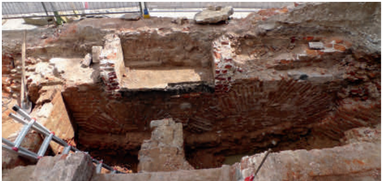
afb. 23: De zuidmuur met de herstelwerken: twee spaarbogen die op de oude funderingen steunen en het nieuwe muurwerk dragen (Stad Gent, De Zwarte Doos, Stadsarcheologie)
