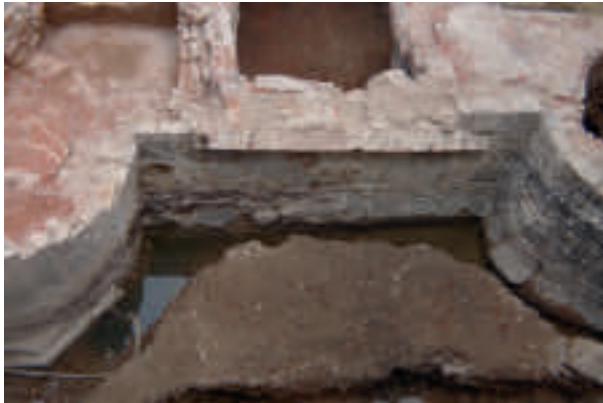
afb. 28: De bewaarde verjonging in het opgaande muurwerk en de latere boogaanzet van de brug (Stad Gent, De Zwarte Doos, Stadsarcheologie)
