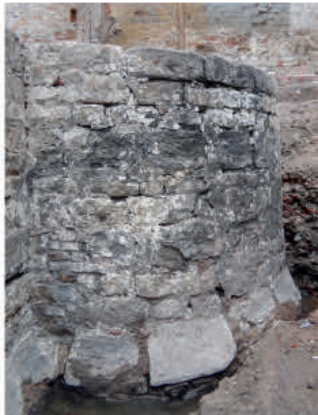
afb. 27: Het natuurstenen en plaatselijk herstellde buitenparement van de beide torens: de herstellingen werden weggewerkt met een witte kalklaag (Stad Gent, De Zwarte Doos, Stadsarcheologie)
