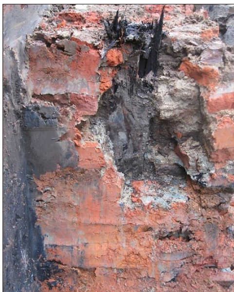
Figuur 157 Heipalen in het metselwerk van S44
