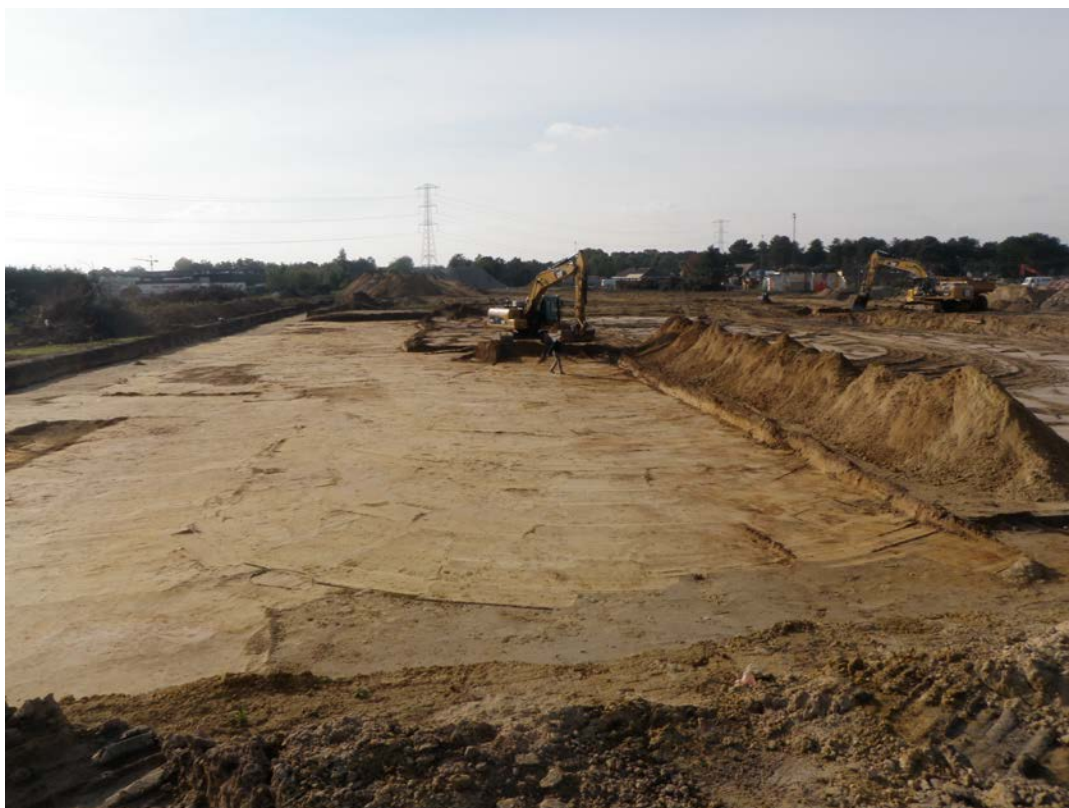
Afbeelding 2: Aanleg van het vlak in deelgebied 1.
