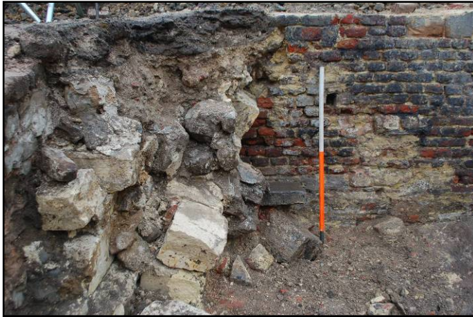
Afb. 58: I64: detail van de aanzet van het gewelf.
