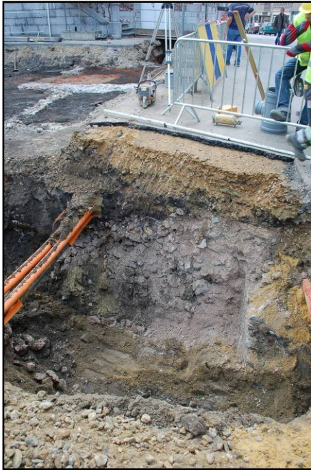
Afb. 70: I80 sleuf voor het stadhuis
