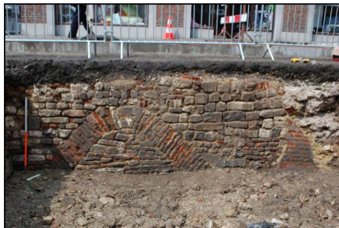
Afb. 60: I64: spaarboog in de noordwestelijke muur
