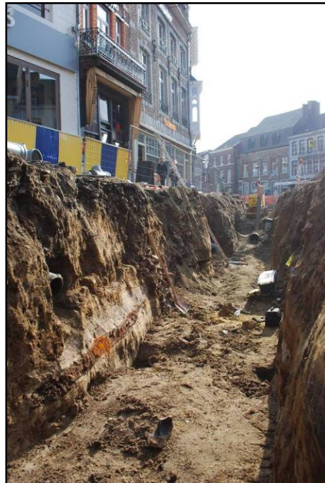
Afb. 9: 18, zicht op de rioleringsleuf.
