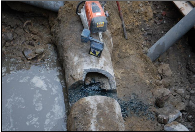
Afb. 7: zicht op de rioolbuis ter hoogte van de Kloosterstraat (foto ARONbvba).
