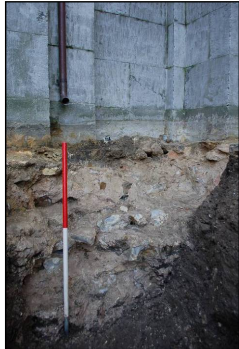
Afb. 23: I34, Romeinse muur.
