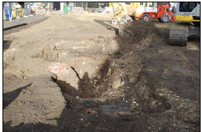
Afb.16: I18, uit baksteen gemetste waterput met koepelgewelf, aangelegd binnen de resten van een straatkelder met mergelstenen gewelf.
