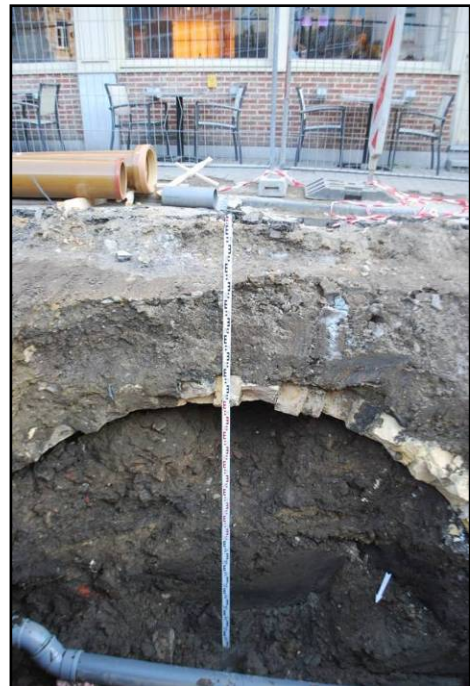
Afb. 6: I5, gewelf van een straatkelder in mergelsteen in het zuidprofiel.
