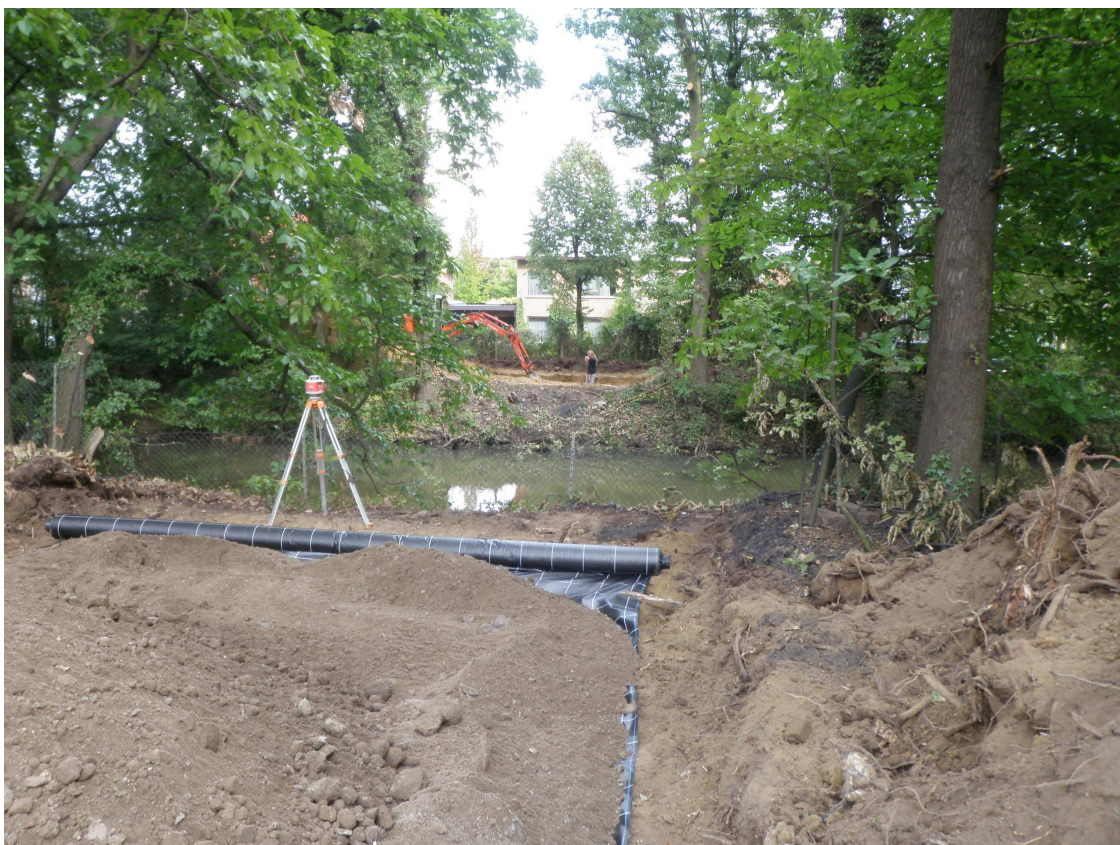
Afbeelding 3: Locatie nieuwe brug. Aanleg werkput 3 gefotografeerd vanuit gedeeltelijk gedempte werkput 1.
