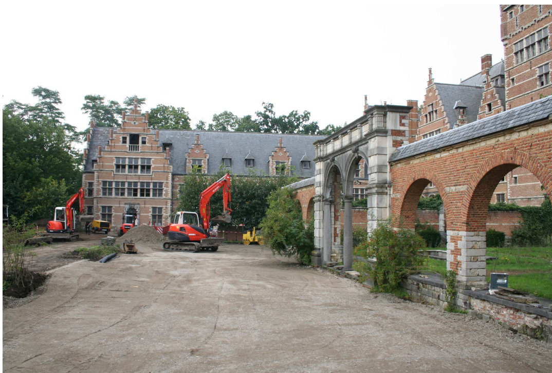
Afbeelding 13: werkput 2 na het toeleggen met geotextiel en puinverharding.
