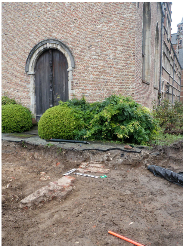
Afbeelding18: 15 e eeuwse muurresten in het verlengde van de kapel na de verbouwing uit de 17 e eeuw.
