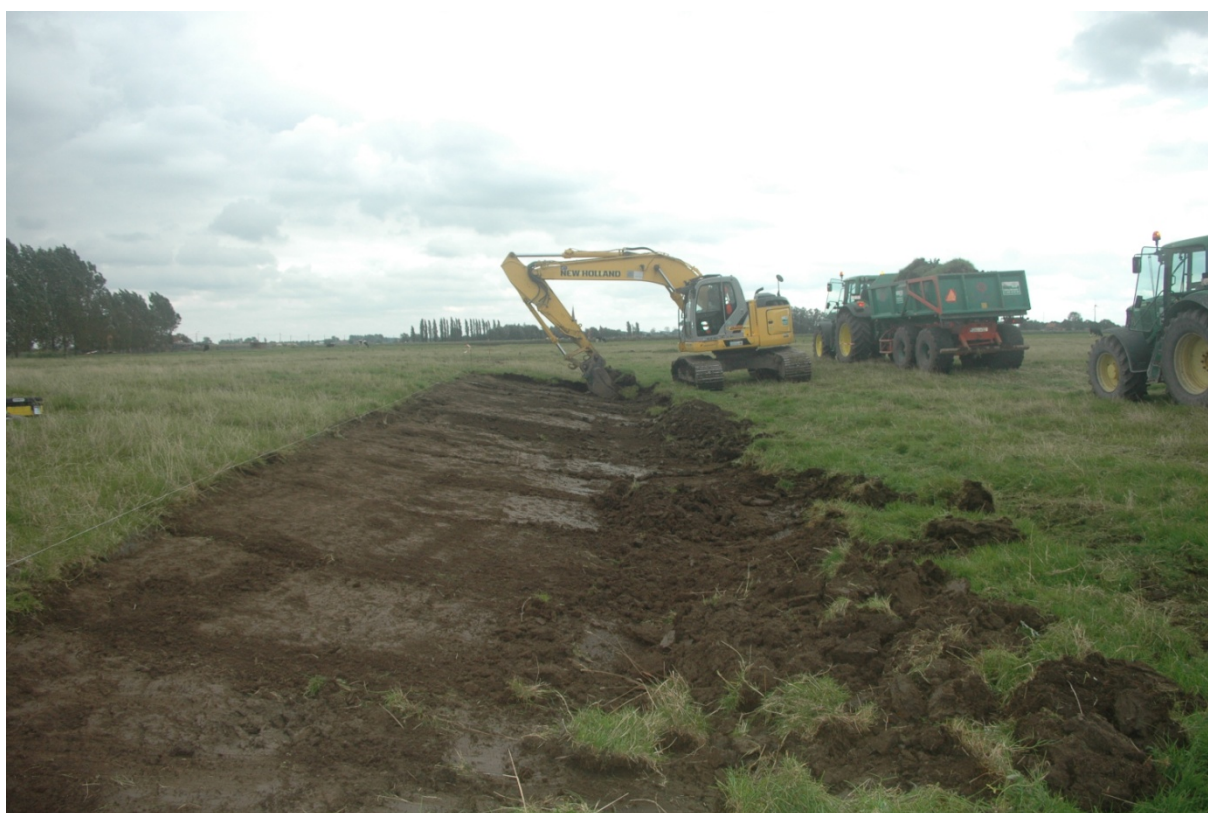
Fig. 5 Uitgraven van de noordelijke walgracht
