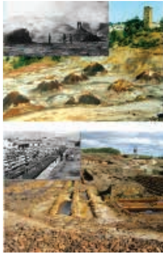
Figura 3. Presente y pasado de la zona de calcinación, donde aún se conservan algunos montones de pirita tostada al aire libre y restos de los canales de cementación.
