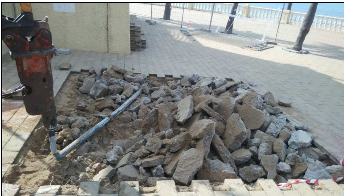
Fig. 3.8. Retirada de la solería y hormigón del sondeo
