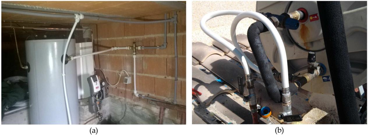
Figura 5-3. Tuberías sin aislamientos y no aptas para ACS.
