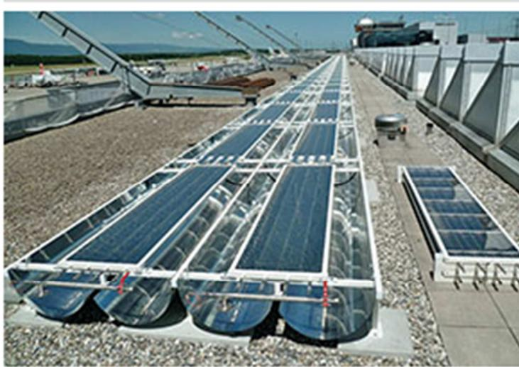
Figura 3-4. Captador solar plano con tecnología UHV, fabricado por SRB Energy
