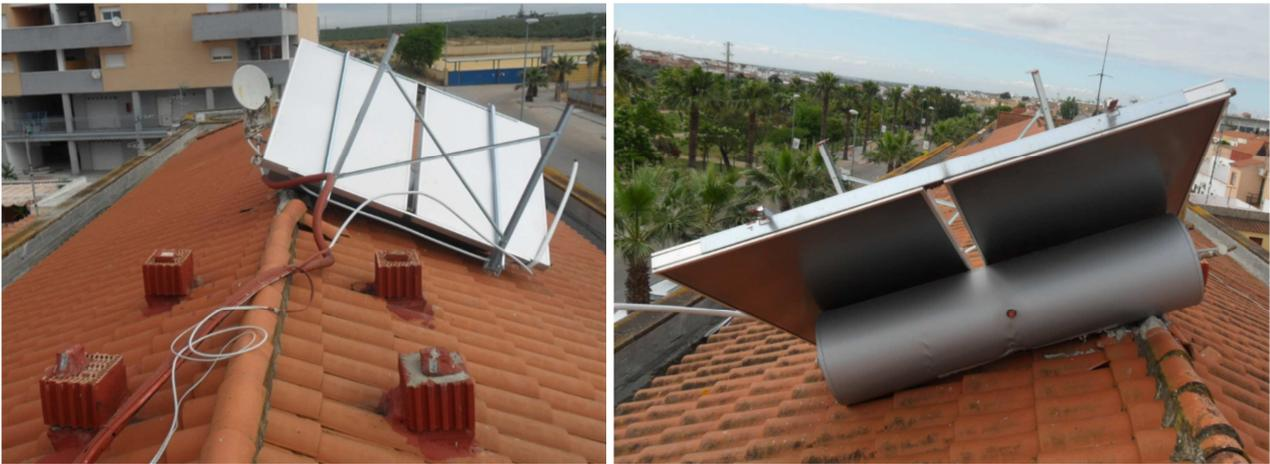
Figura 5-1. Equipos mal anclados.
