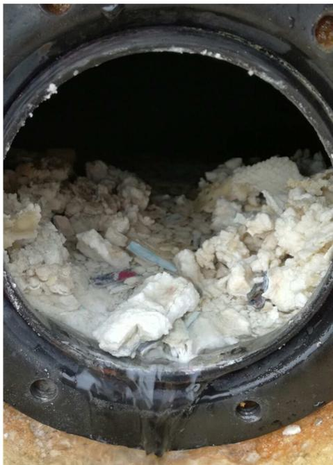
Figura 5-18. Depositiones de cal en el interior del acumulador
