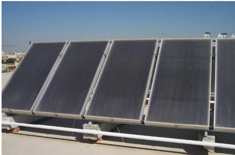
Figura 3-15. Captador solar térmico
