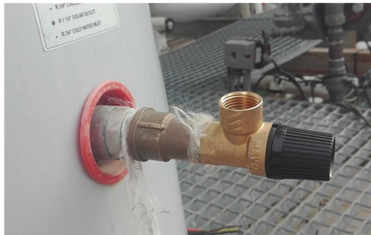
Figura 5-5. Válvula con boca de salida por la parte superior.
