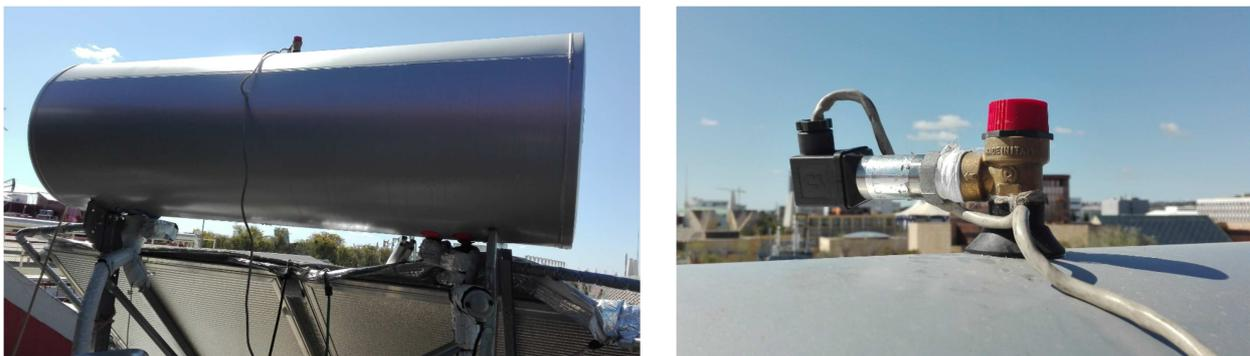
Figura 7-62. Posición válvula de seguridad
