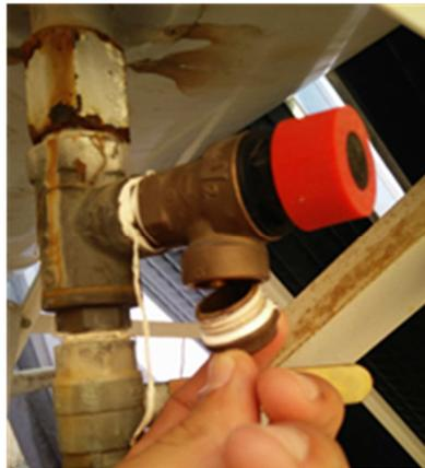
Figura 5-4. Válvula de seguridad con tapón a la salida.
