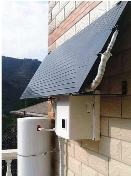
Figura 3-1. Sistemas solares térmicos de ACS y apoyo a la calefacción. Sistema de circulación forzada (a).
