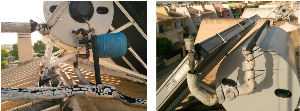
Figura 5-12. Aislamientos en mal estado.
