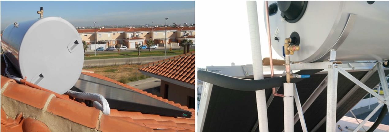
Figura 5-6. Sifón en sistemas termosifónicos.
