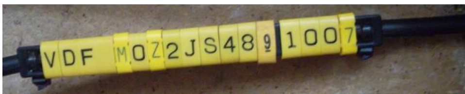
Figura 77 – Codificação do cabo[43]
