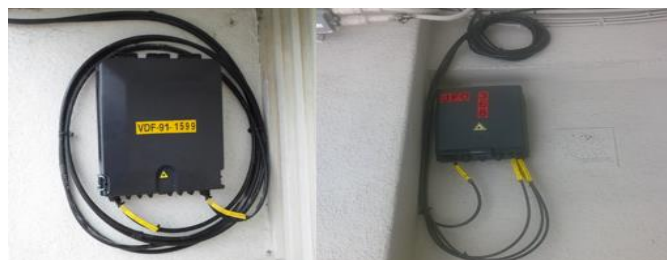
Figura 91 – PDO de fachada e JFO de fachada[43]
