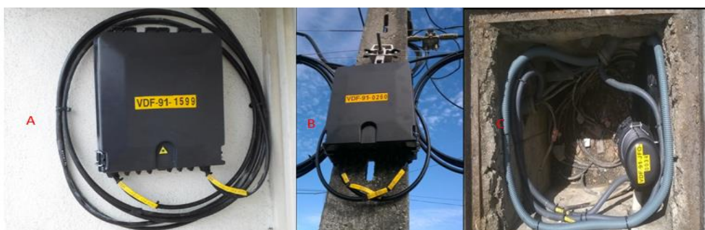
Figura 60 – PDOs de Fachada, Poste e CVP[43]
