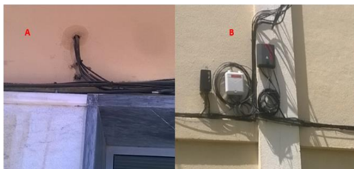
Figura 67 – Alimentação Rita-Fachada e por fachada[43]
