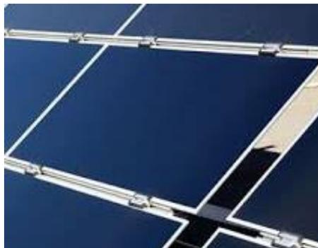
Figura 2.18 – Sistema FV de CdTe
