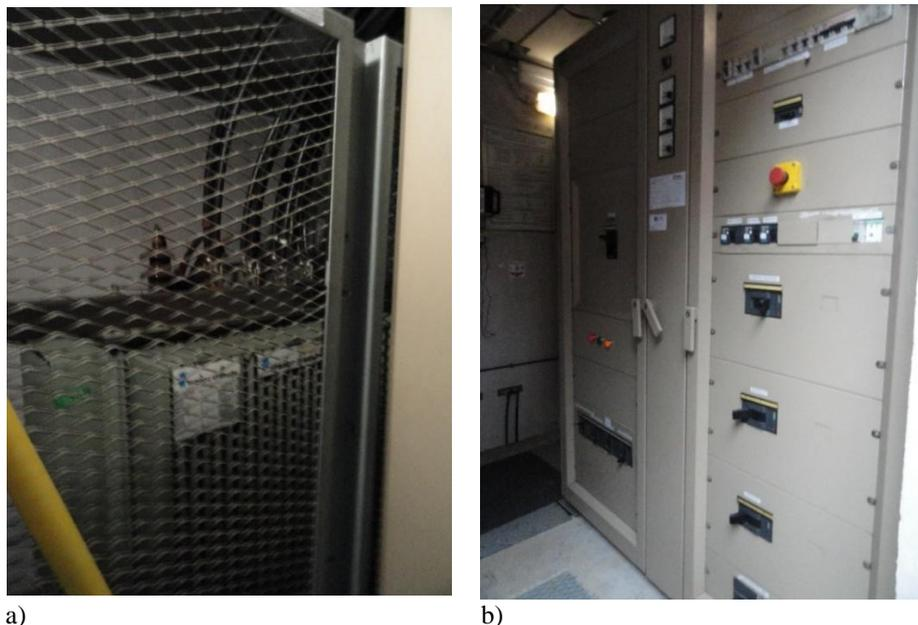
Figura 4.9 – a) TP do PT<sub>2</sub>; b) QGBT do PT<sub>2</sub>
