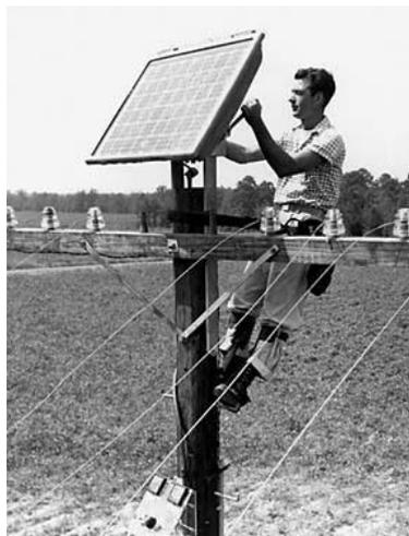
Figura 2.8 – Primeira aplicação de uma célula solar de silício foi na alimentação de uma linha telefónica da rede local, estado da Georgia, Estados Unidos da América, 1955
