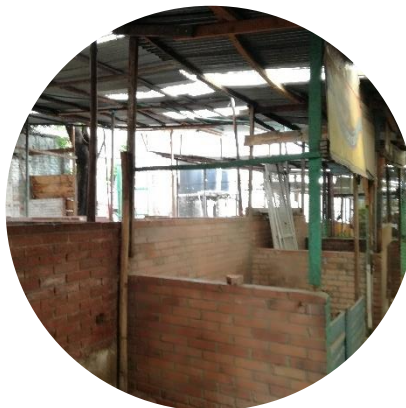
El Edificio Adyacente
