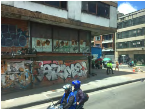
Imagen 22. Edificio abandonado, Cll. 21. Fotografía propia.
