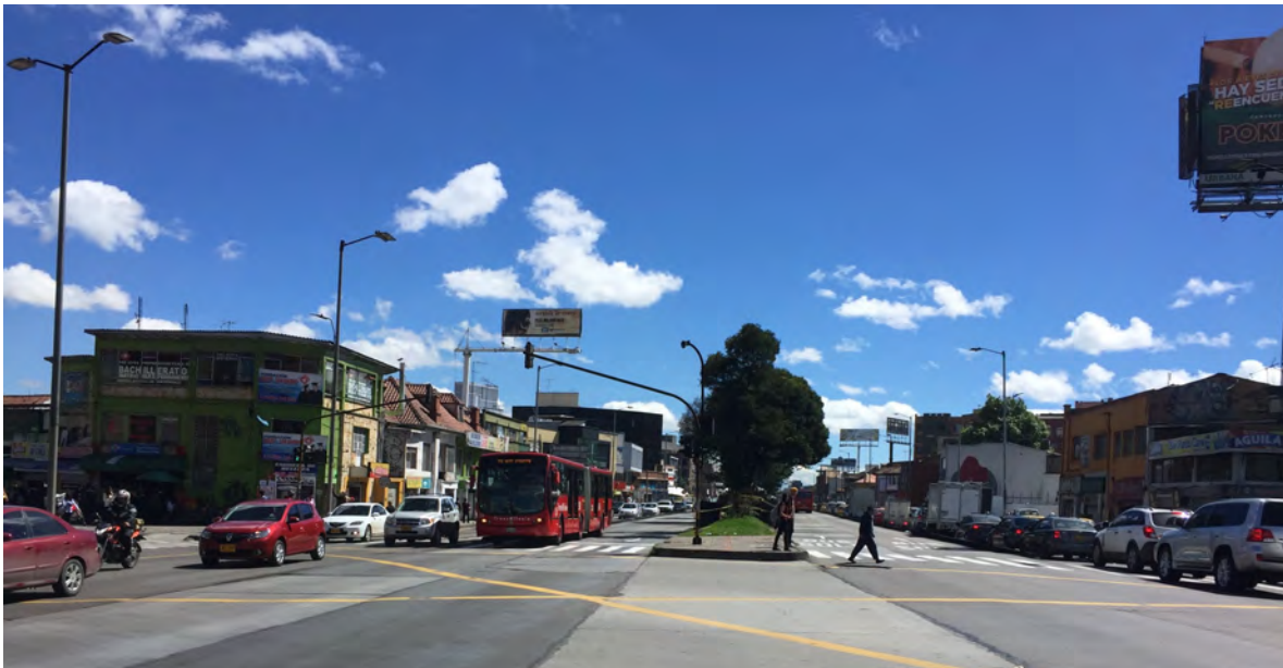
Imagen 8. Perfil de la troncal en la intersección con la Calle 72 Fotografía propia.
