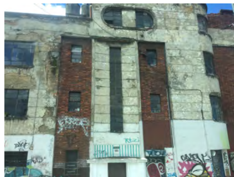
Imagen 23. Edificio abandonado, Cll. 23. Fotografía propia.
