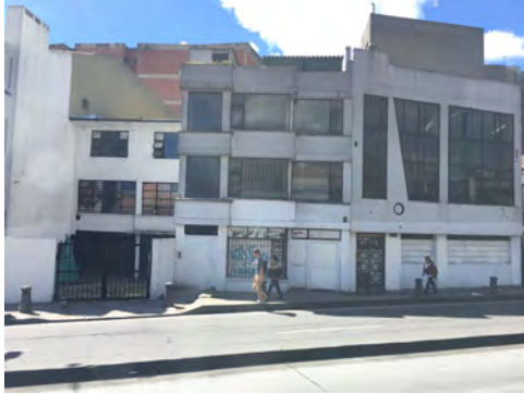
Imagen 20. Edificio abandonado, Cll. 74. Fotografía propia.
