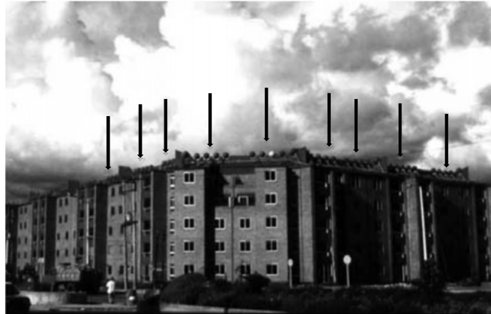
Figura 1. Vista parcial de los 1250 calentadores solares instalados por el Centro Las Gaviotas a mediados de los ochenta en Ciudad Salitre, Bogotá.
