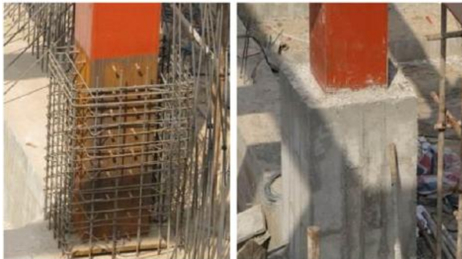
Ilustración 6. (a) Columna tipos CSFT durante la construcción, (b) Sección típica, (c) Ruta de carga. Fuente: Tomado de referencias (An & Han, 2014) , Pág. 316.
