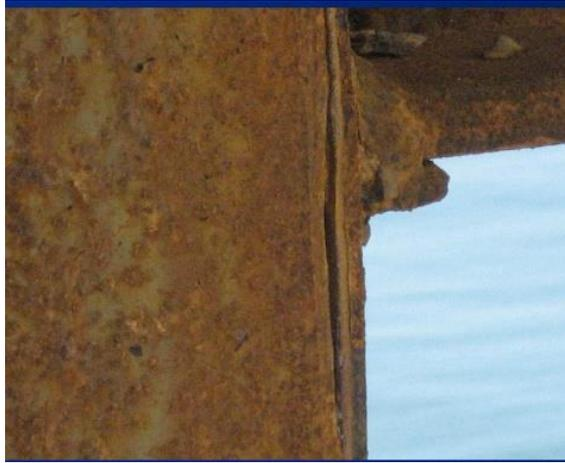
**Figura 51.** Detalle rotura en nudo (Garza y Orozco 2008)
