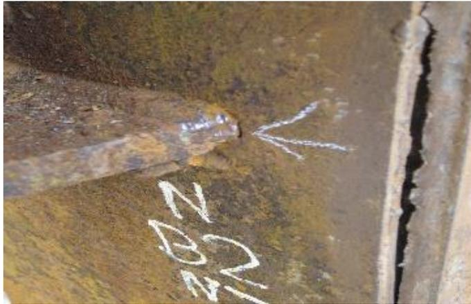
**Figura 55.** Detalle rotura en nudo (Garza y Orozco 2008)
