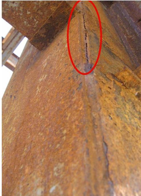
**Figura 52.** Rotura soldadura vertical (Garza y Orozco 2008)
