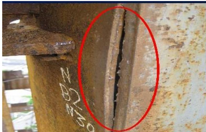
**Figura 54.** Detalle rotura vertical y pandeo (Garza y Orozco 2008)
