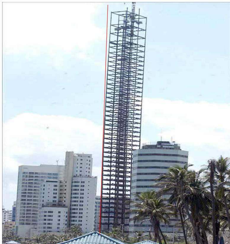
**Figura 57.** Desplazamiento de 1m en el eje (x) de la Torre LA Escollera
