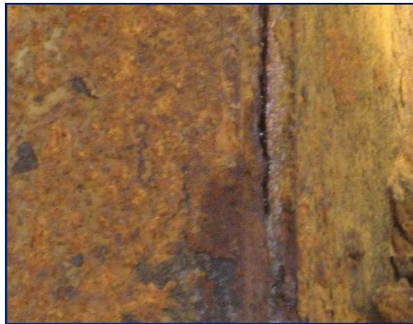
**Figura 50.** Detalle rotura soldadura en Columna (Garza y Orozco 2008).
