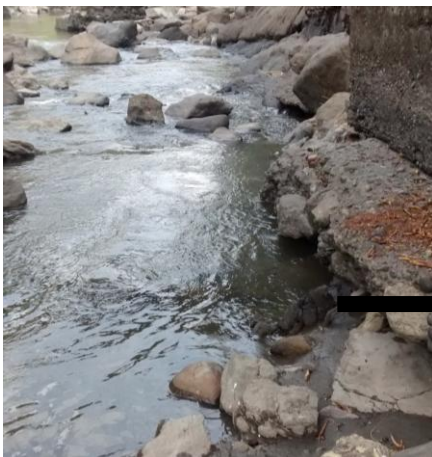
Figura 12- Estribo derecho socavado - Puente Sunuba
