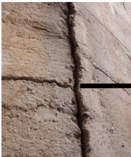
Figura 13-Separación entre el estribo derecho y la aleta – Puente Sunuba
