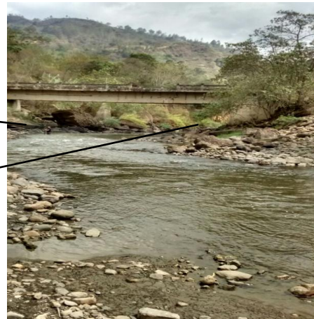
Figura 20- Estribos Río Sunuba
