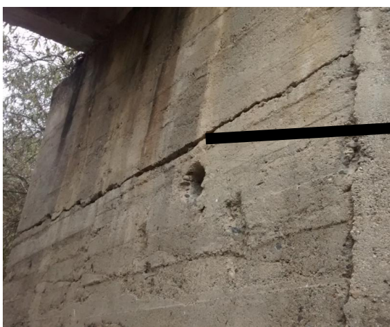
Figura 14- Grieta en estribo derecho – Puente Sunuba
