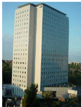
Figura 34. Edificio BRD-Société Générale Bank, Rumania (Aldea y Demetriu, 2006)
