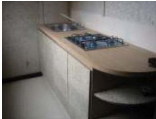
Figura 27. Mesón de cocina hecho en Ecoplak, combinado con madera. Tomado de Riorion S.A. (S.F)
