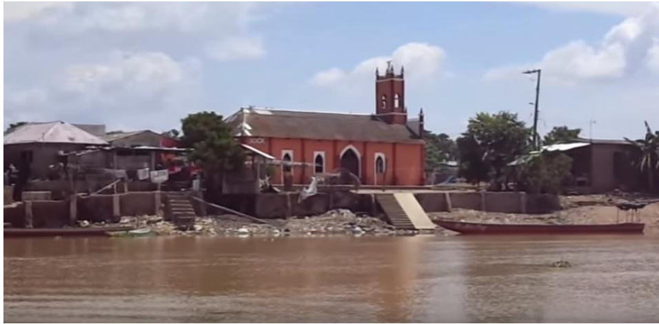
Figura 85. Fotografía tomada por pobladores en época de inundaciones, fecha de entrada al blog electrónico Octubre de 2012. Imagen del río San Jorge y la Iglesia de La Jegua en épocas de niveles de agua bajos. Fuente: (Vergara, 2016).
