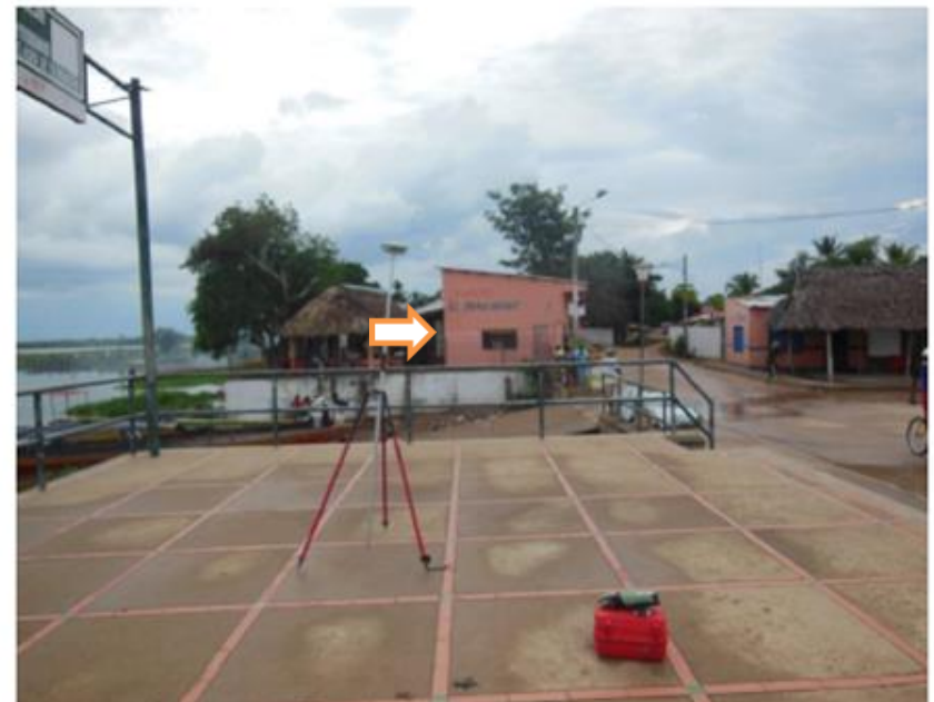
La flecha indica el nivel de la huella de inundación
