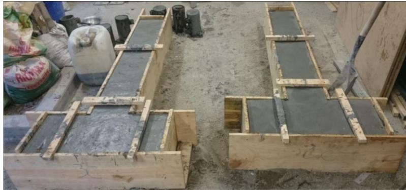
Figura 64. Fabricación de vigas en voladizo.
