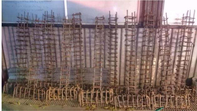
Figura 63. Armado de vigas en voladizo
