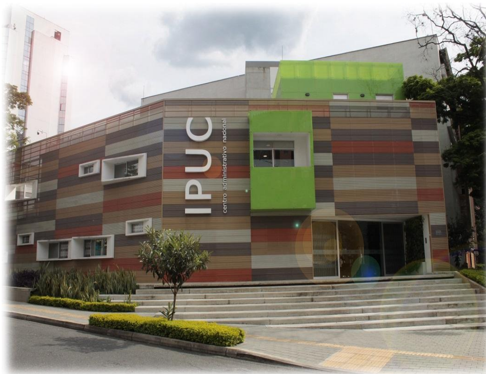
Imagen 1. instalaciones Centro Administrativo Nacional IPUC.
