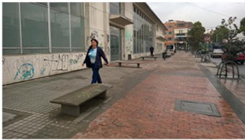
ESTADO ACTUAL CARRERA 79 COSTADO NORTE
