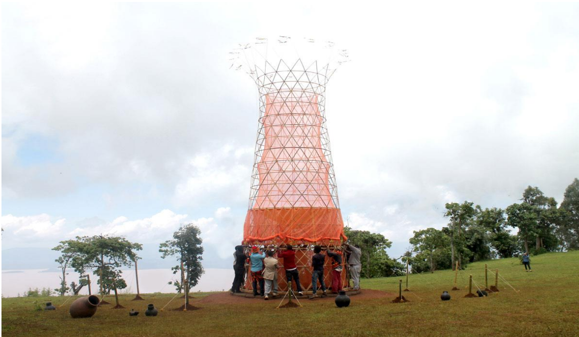
Figura 45. Construcción de un Warka Water. Tomado de http://www.warkawater.org/design
