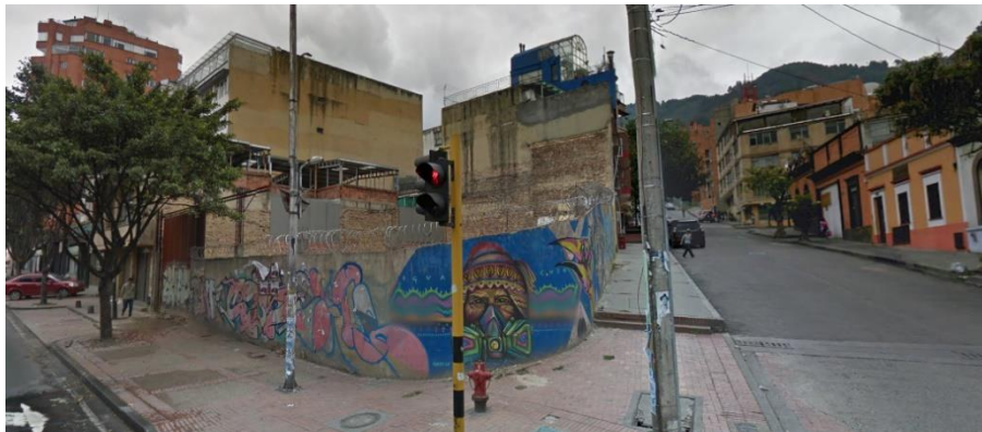
Figura 4. Cra 5 con calle 28: Lote baldío con licencia de construcción vigente. Tomado de Google Maps.
