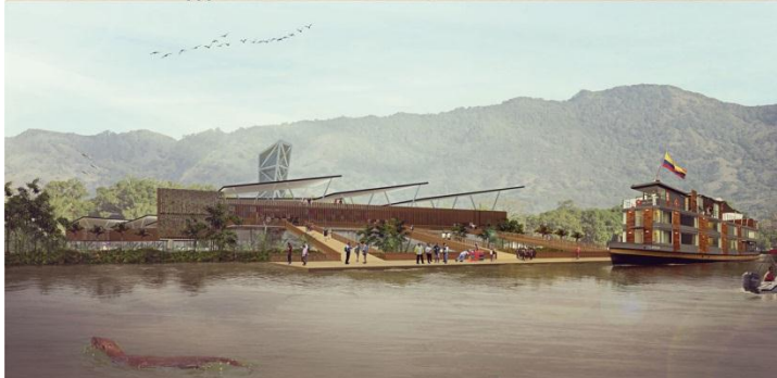
APROXIMACIÓN AL PUERTO MULTIMODAL NUEVO CENTRO - RIÓ MAGDALENA
