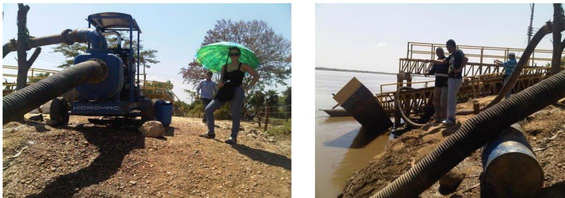
*Figura 20. Afectación barcaza y bombeo provisional*
