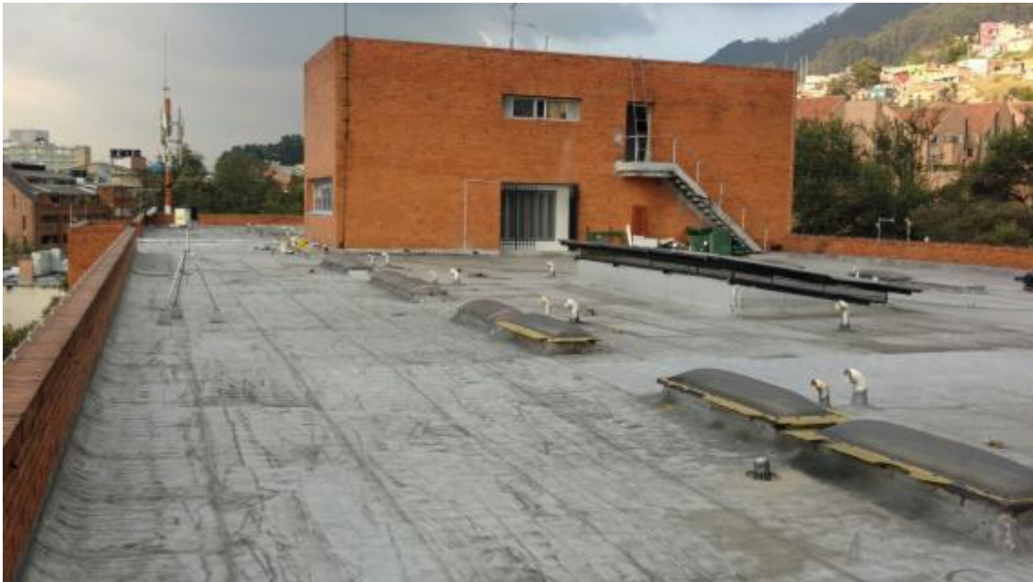
Fotografía 1. Cubierta edificio Rafael Arboleda
