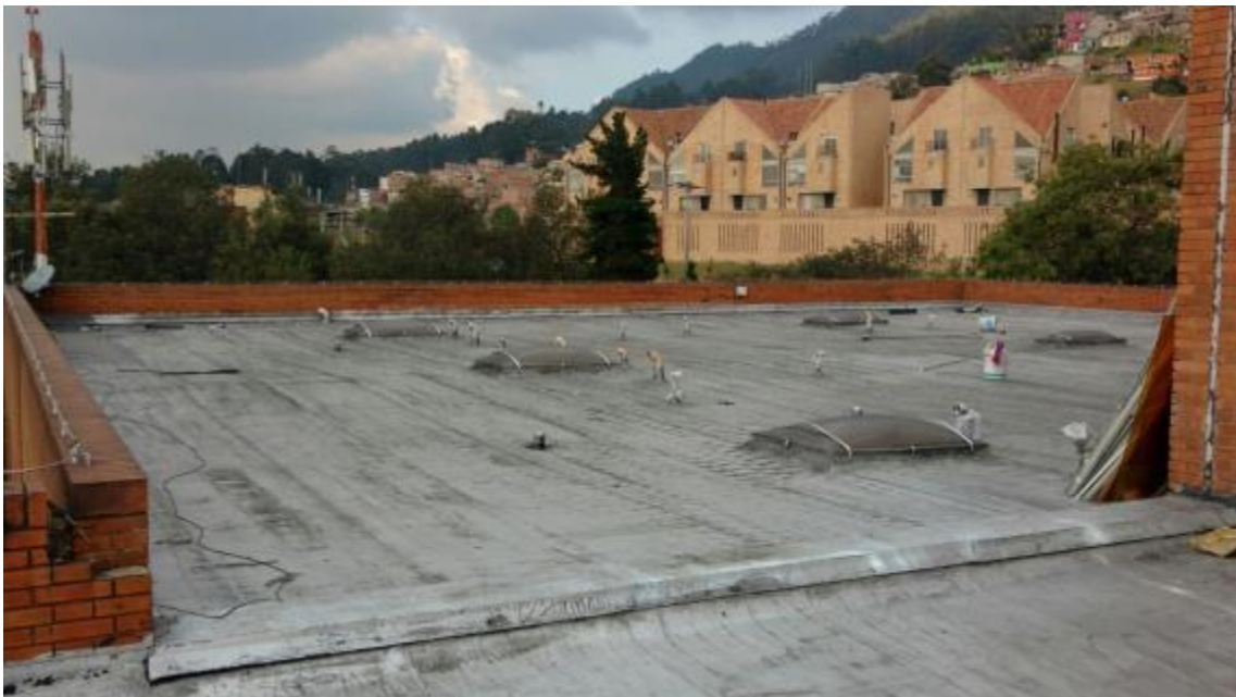
Fotografía 2. Cubierta edificio Rafael Arboleda
