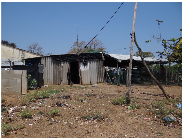
Imagen 4. “Albergue Las Compuertas” Fotografía tomada por: Alejandra Jiménez
