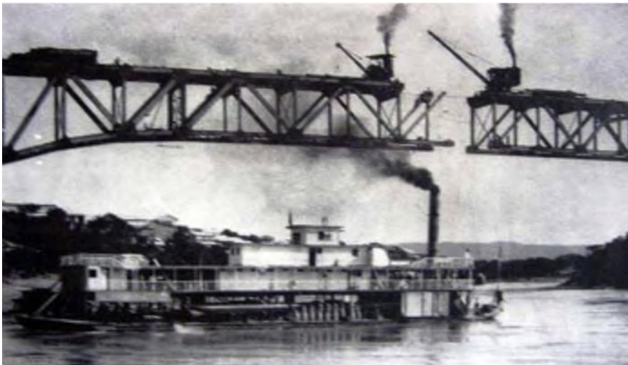
Imagen 13. Construcción del puente del ferrocarril sobre el Río Magdalena a la altura de Girardot. Se observa la relación de los vapores, que eran los encargados de llevar los materiales de construcción del puente, además de conectar mercantilmente los asentamientos alrededor del Río Magdalena.
