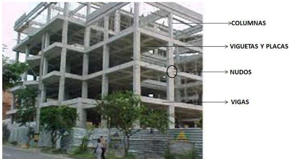
Figura 1. Sistema aportricado ( http://estructuras.eia.edu.co/estructurasI/indest1.html , s.f.)
