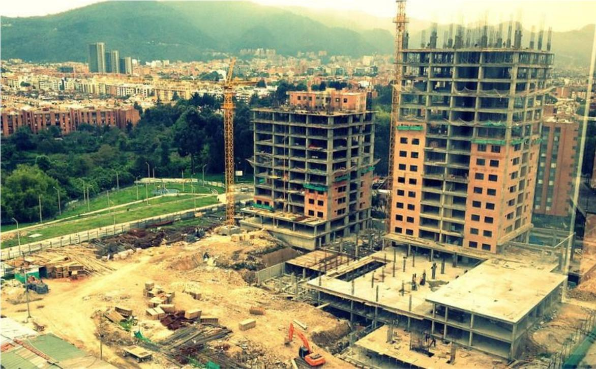
**Figura 5. Edificación construida mediante MC (Delta ingeniería S.A., 2013). También conocido como sistema tradicional en Colombia.**
