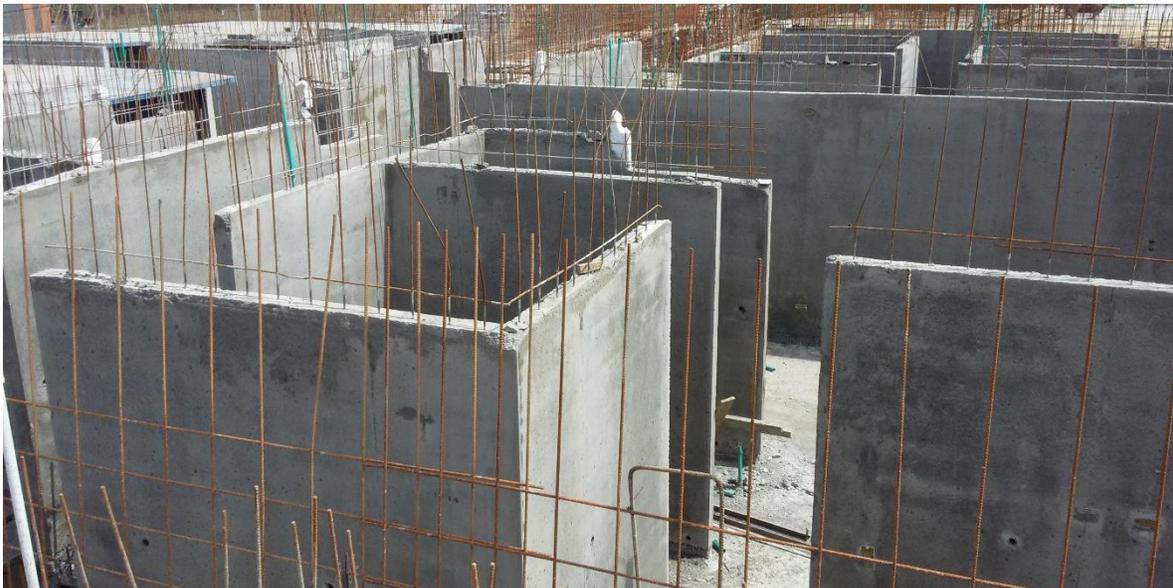
**Figura 4. Muros estructurales de edificación VIS en SI, del proyecto Cala en Ciudad Verde, fundidos con formaleta Outinord, compuesta por banches y mesas.**
