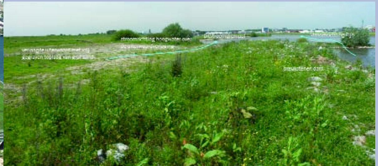
5.13 • Zicht op de uitstroom van de verlaagde uiterwaard in de Bakenhof. Rechts is de rivier zichtbaar en een breukstenen zomerkade, links is het verlaagde deel zichtbaar met een zandige toplaag en pioniervegetatie (foto Bart Peters).
