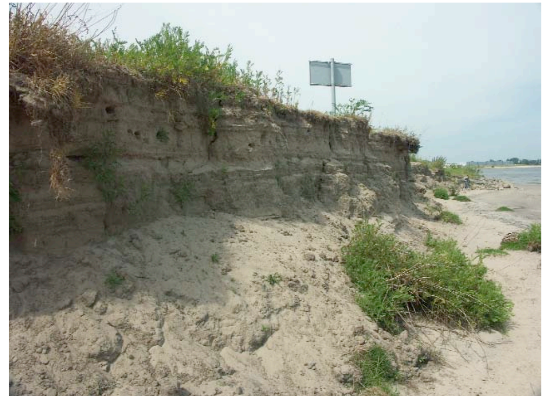
B.5 • Zandige oeversteilwand met oeverzwaluwen bij de instroom van een kleine nevengeul bij Gameren (foto Bart Peters).
