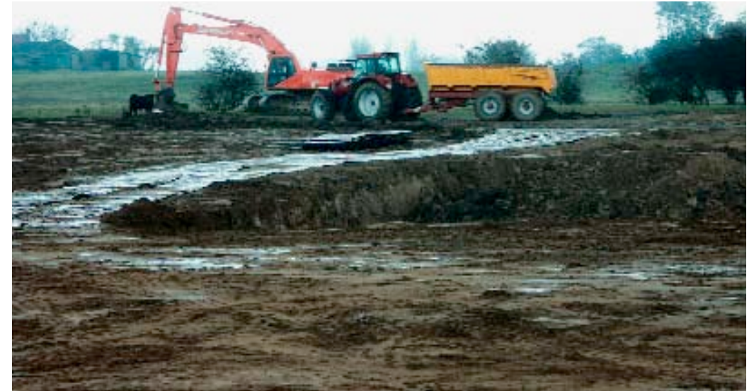
8.3 • Het afgraven van roofgrond en klei in de Millingerwaard (foto Bart Peters).
