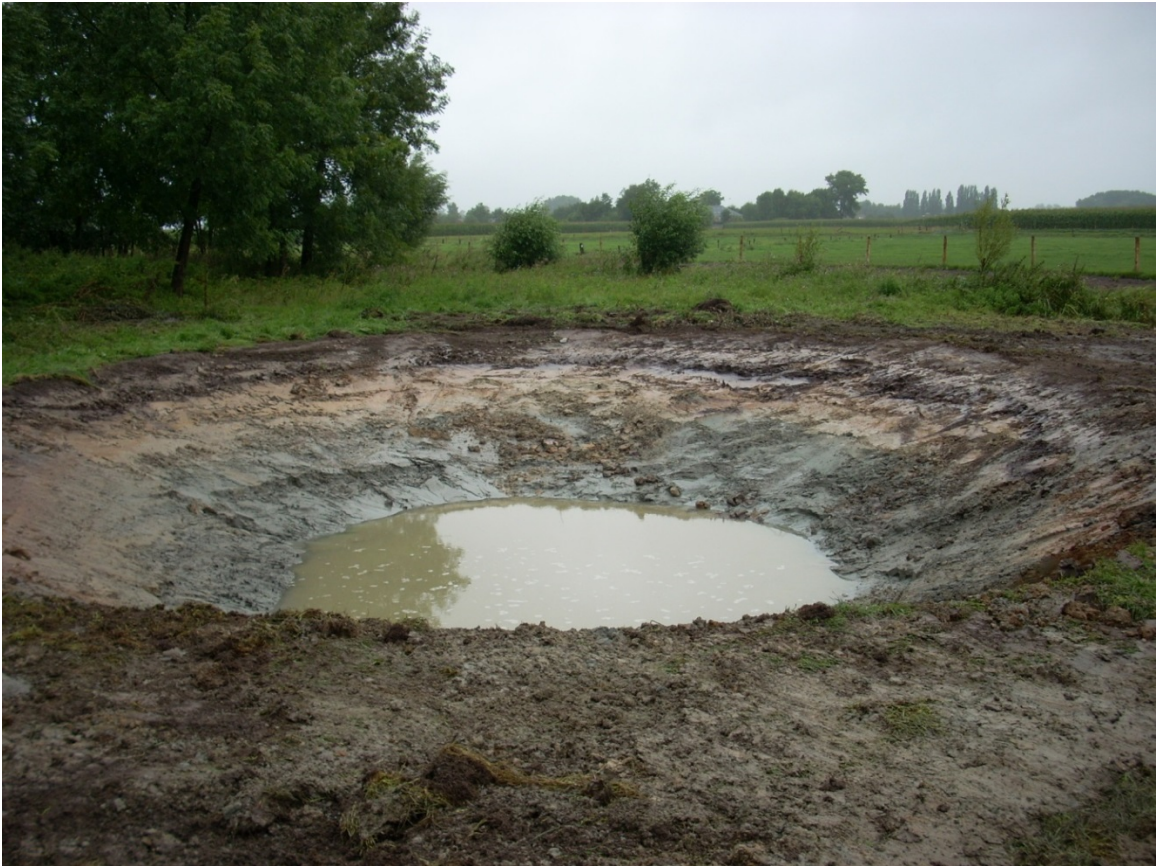
Fig. 8: Overzichtsfoto van een van de uitgegraven poelen waarbij de bodemopbouw duidelijk zichtbaar is
